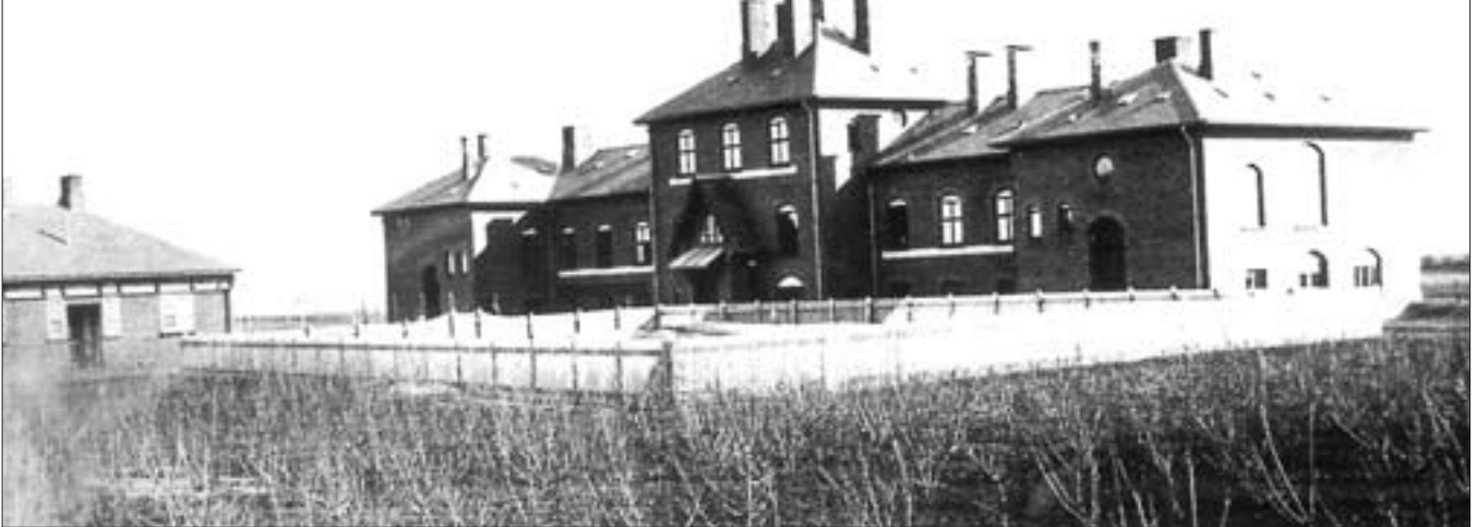
Det nyopførte Amts og Bys Sygehus. Den lille bygning til venstre rummer vaskehus, tørrestue, desinfektionsovn og ligstue
