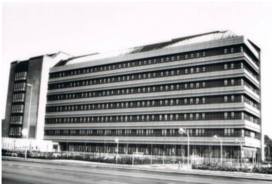
Højhuset – efter at billedet er taget er der kommet en overbygning på modtagelsen som ses nederst til venstre.
