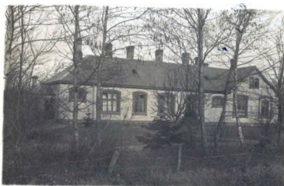
Sygehuset i Brovst Thisted amt havde samtidig åbnet sygehus i Fjerritslev
